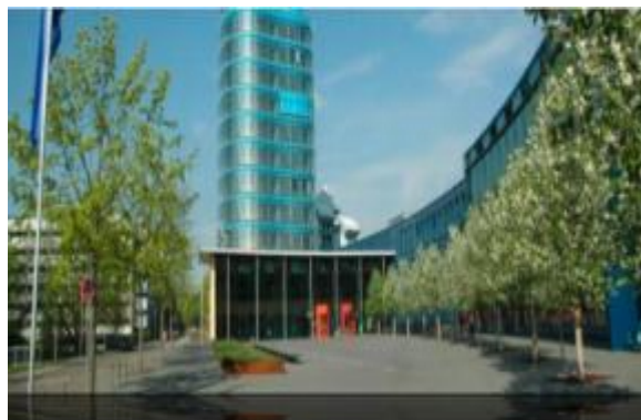
海大教学大楼
