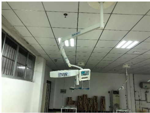
临床医学院查勘现场
