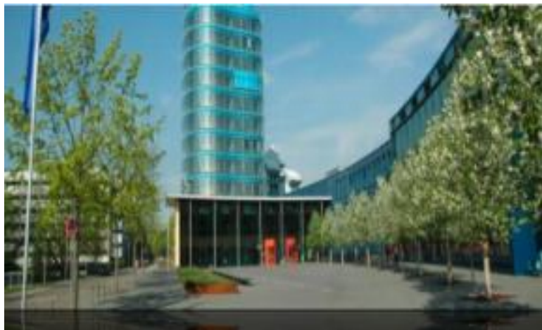
海大教学大楼
